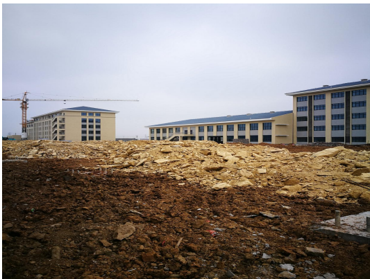
探伤房拟建址南侧
