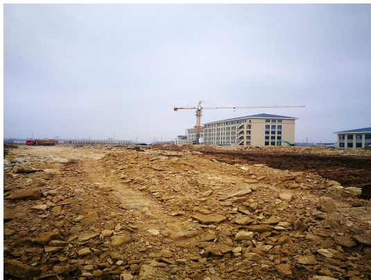
探伤房拟建址东侧
